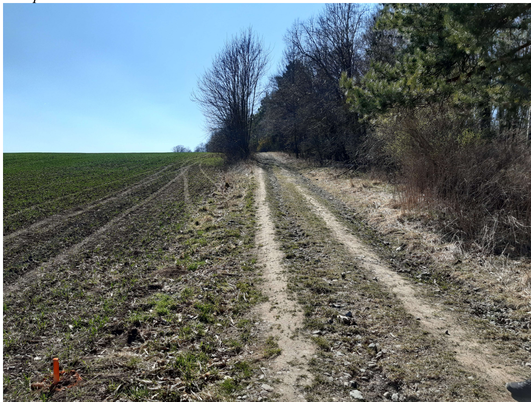
Obr. 4 – pohled na polní cestu C10 – úsek s vyšším podélným sklonem – zpevnění silničními dílci, kolejová úprava + levostranný lichoběžníkový příkop
